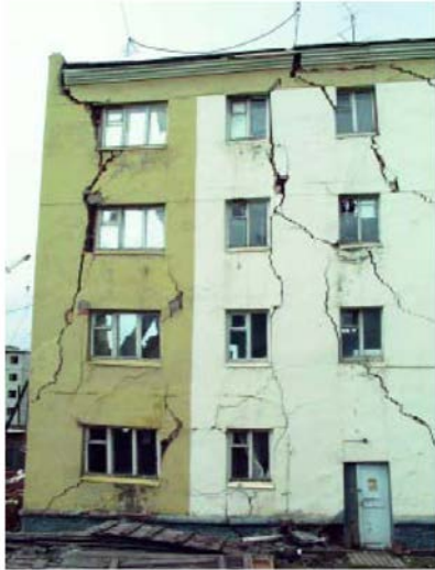
Schäden durch auftauende Permafrostböden, Russland. Quelle: Arctic Climate Impact Assessment, 2004.
