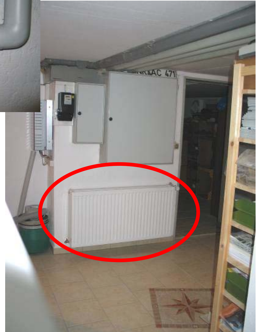
Radiatoren-Heizkreis für EG/DG abgesperrt im Sommer
