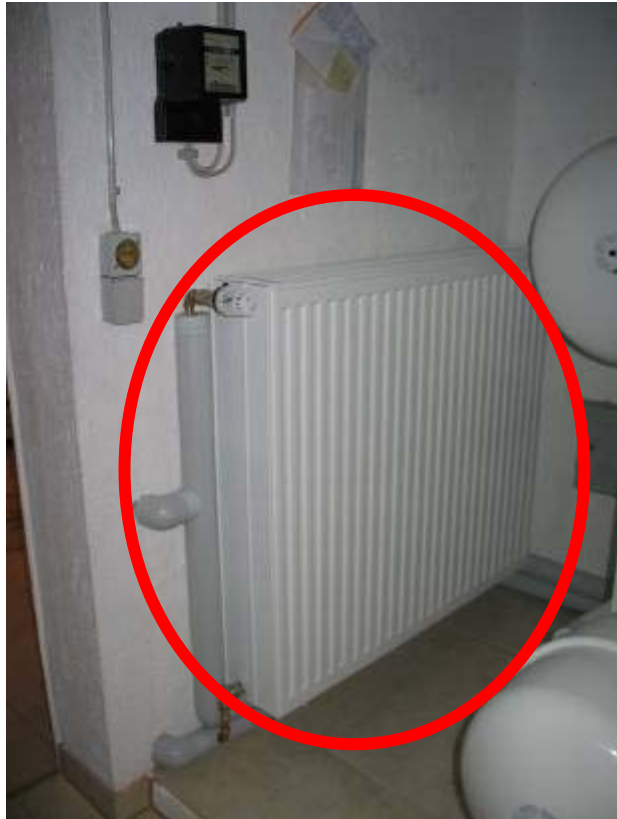
Radiatoren-Heizkreis für EG/DG abgesperrt im Sommer
