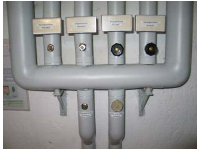
Radiatoren-Heizkreis für EG/DG abgesperrt im Sommer
