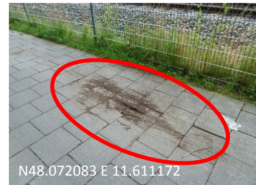
Teilweise Absenkung der Platten
